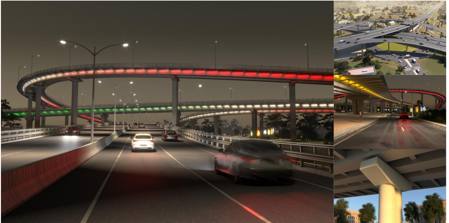
Intercambiador Suame Circle
