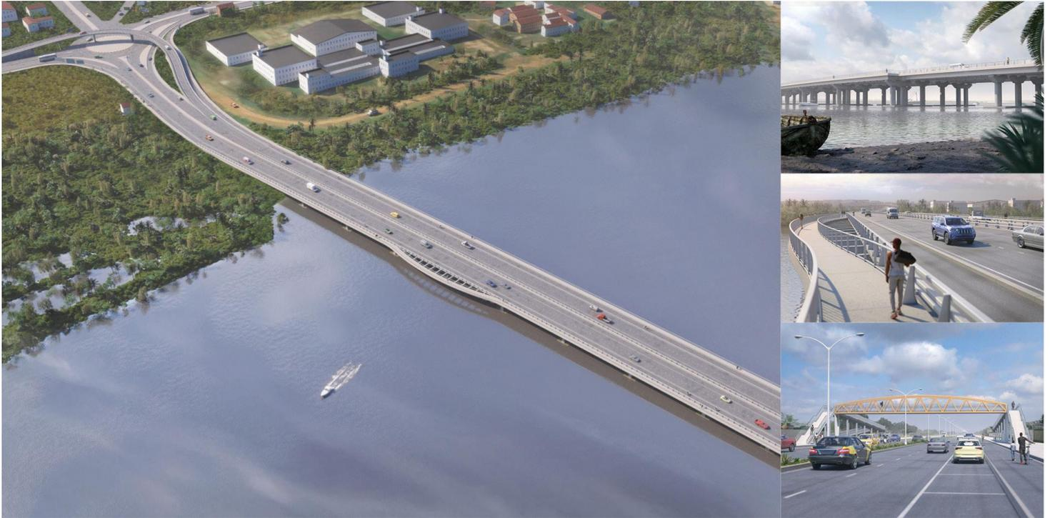
Proyecto preliminar de una conexión vial entre el cruce de Sèmè y Porto-Novo con la construcción de un puente sobre la laguna y la conexión de 2x2 carriles con el Boulevard du Cinquantenaire.
