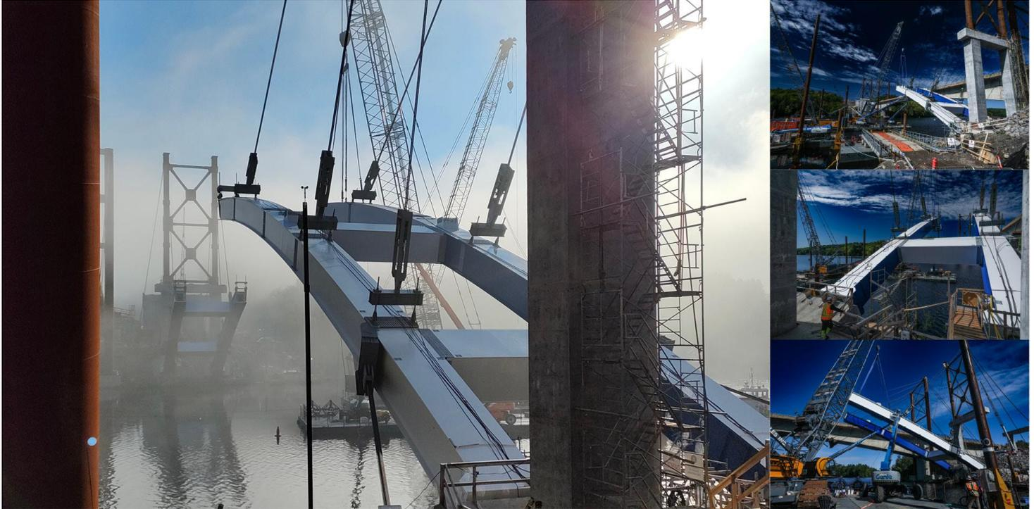
El nuevo puente de Pont Des Piles se trata de un puente arco de acero de 180 m de luz bastante rebajado. El tablero consiste en una sección mixta de vigas de acero doble T y una losa de hormigón sobre ellas.
