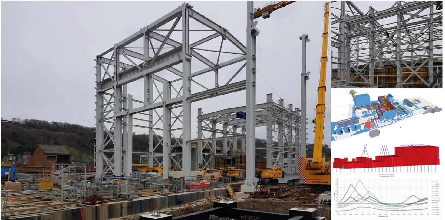
Nueva Central Térmica de Turbina de Gas de Ciclo Combinado con una capacidad de producción de 875 MW situada en un emplazamiento propiedad de ENGIE en Les Awirs, en la provincia de Lieja, en la región de Wallon, Bélgica. La Unidad tendrá una configuración de ejes múltiples y constará de una turbina de gas (GT), una de tipo tambor con tres niveles de presión, un generador de vapor con recuperación de calor y una turbina de vapor (ST) de salida lateral.
