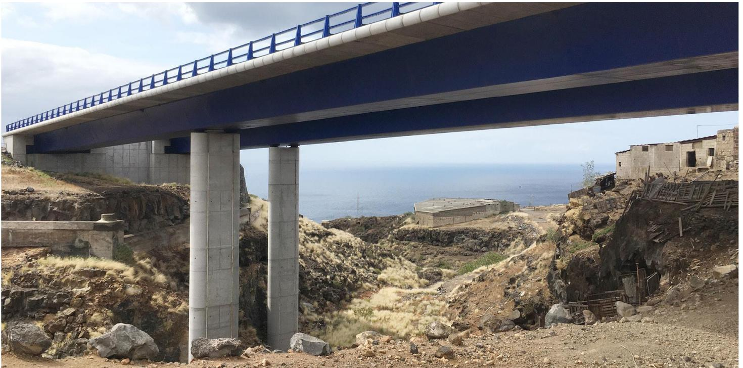
Viaducto doble mixto con 92m de longitud y 63,5m de vano máximo
