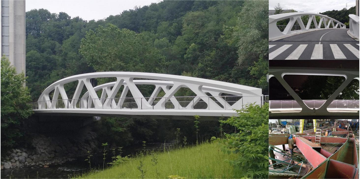
El nuevo puente conecta las instalaciones de Orona situadas en Epele y Lastaola y sustituye a un tablero de hormigón que se ha demolido, manteniendo la geometría en planta del puente y los accesos, y mejorando las condiciones hidráulicas.
