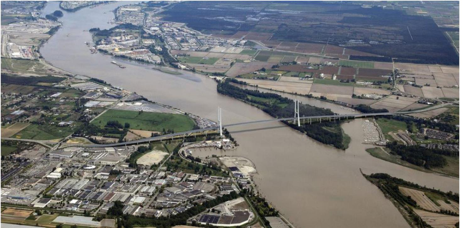
Puente atirantado de 3 vanos y retirada del túnel existente.
