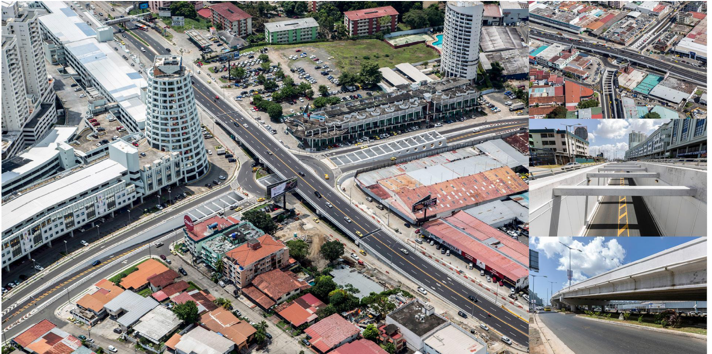
intersecciones urbanas a tres niveles. Viaductos de vigas prefabricadas pretensadas tipo NU-1350
