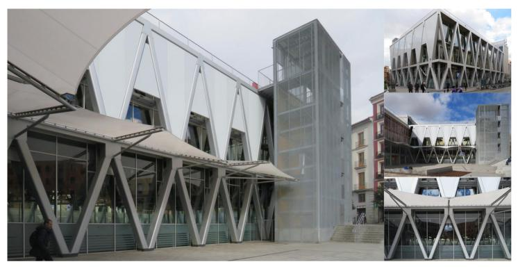
El proyecto se compone de un edificio o volumen sobre rasante con forma de L, adosado al existente Mercado de la Cebada y abriendo una gran plaza de uso público. Este edificio tiene dos plantas subterráneas de diferente geometría, tres plantas sobre rasante y una terraza en el nivel superior. En total cuenta con piscina cubierta, pista polideportiva, gimnasio, vestuarios, y zonas de gestión vecinal entre las que se encuentra la cafetería.
