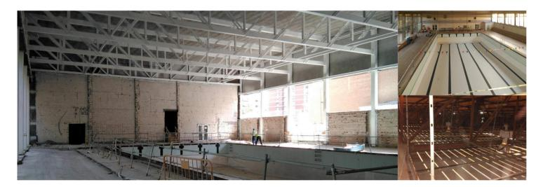
El edificio destinado a piscina cubierta y pabellón tiene una altura de 23,20 m aproximadamente, con unas dimensiones en planta de aproximadamente 62x25 m.
