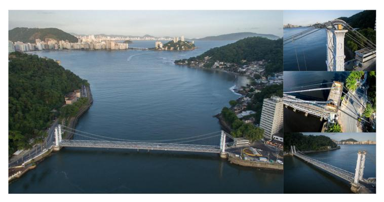
El puente colgante de São Vicente se erigió en 1914 como parte del plan de saneamiento del área de Santos y São Vicente. La condición del puente en 2012 se consideró crítica, ya que algunos elementos en las armaduras habían desaparecido y el cable mostraba corrosión importante y pérdida de sección transversal.
