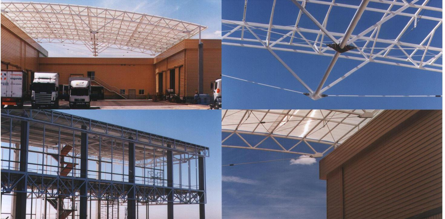
pilares de hormigón prefabricados y cubierta de cerchas metálicas
