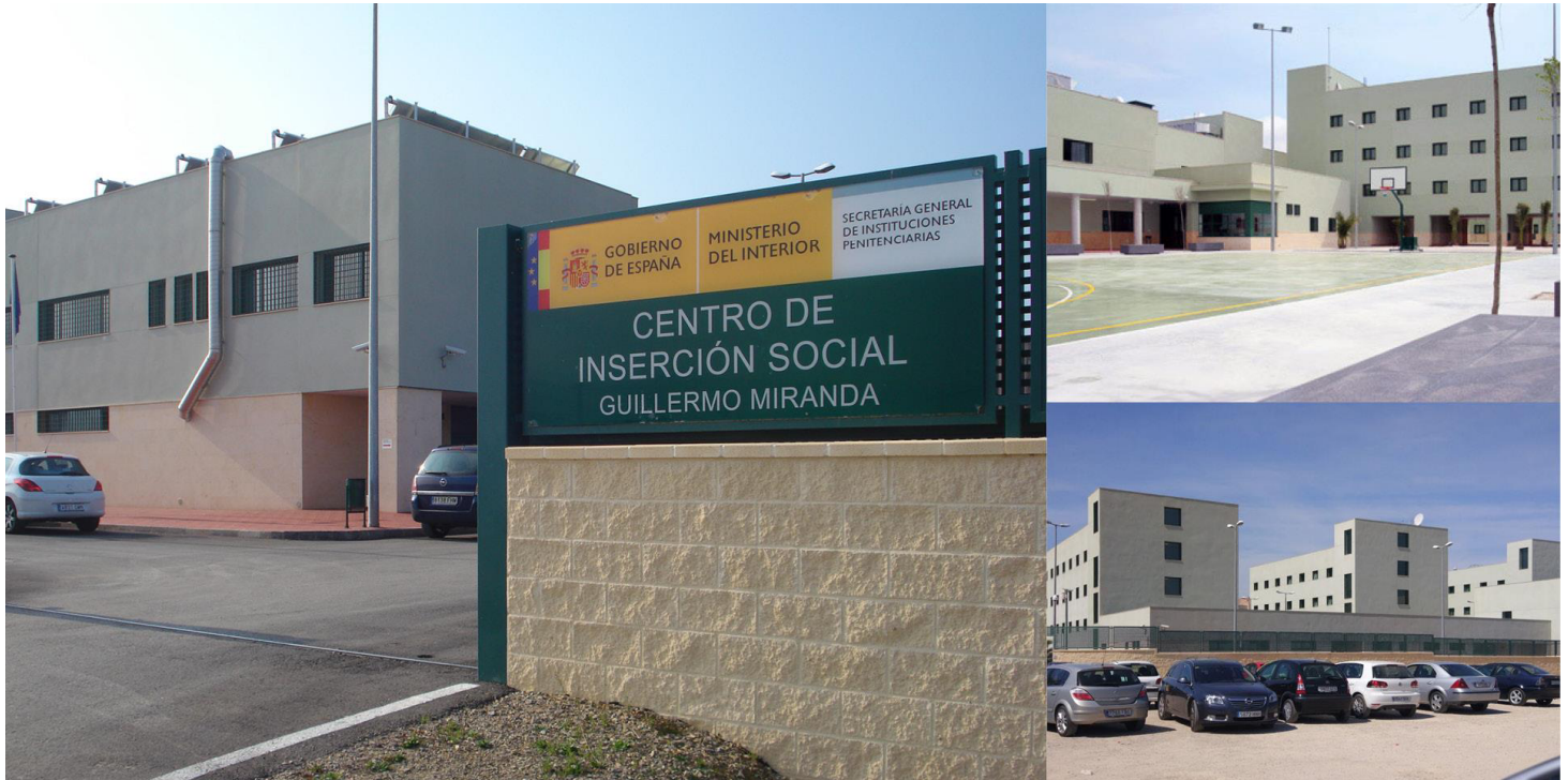
estructura de hormigón armado
