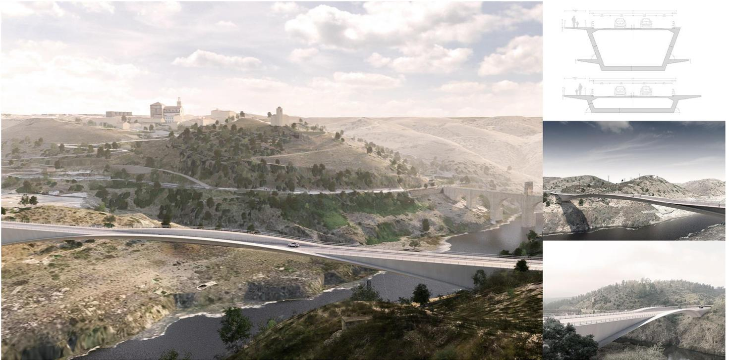
La solución que hemos denominado Ala es un puente con un dintel de hormigón pretensado de tres vanos de canto variable, en la que solo el vano central es visible.
