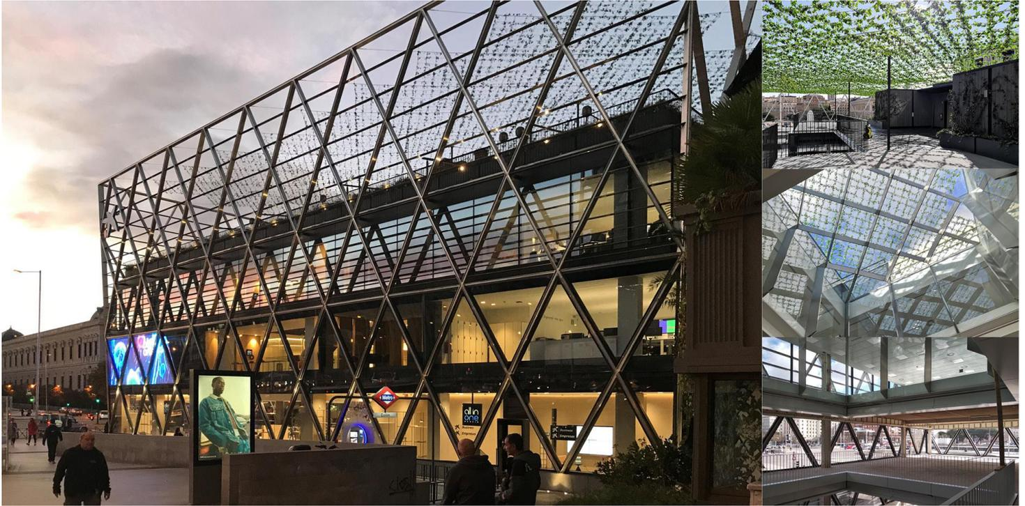
Proyecto de remodelación del edificio existente situado en la Plaza Colón 1. Se adecua la estructura principal al nuevo uso comercial en tres de sus plantas, manteniendo el resto con uso de oficinas. Las actuaciones incluyen la apertura de un gran atrio central en las plantas, la retirada de la fachada existente y ejecución de una nueva fachada en forma de diagrid y una estructura de catenarias que permitirá crear un jardín en la cubierta.
