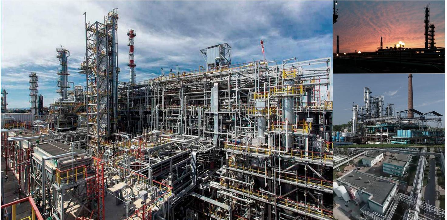
El Proyecto de Hidroproceso de la Refinería de Khabarovsk consistió en una importante expansión de la refinería de Khabarovsk existente, para aumentar la capacidad de la planta, mejorar el rendimiento y abordar los requisitos rusos e internacionales para la reducción del contenido de azufre de los productos de queroseno y diesel.
