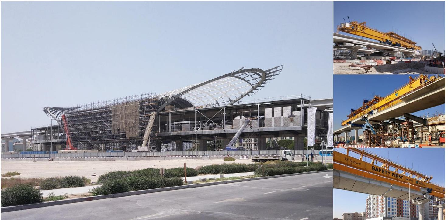
Revisión independiente de viaductos y optimización de cubiertas de estaciones de la línea 2020 del metro de Dubai.
