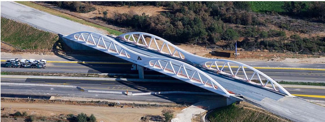
Figura 26. Vistas del puente terminado
