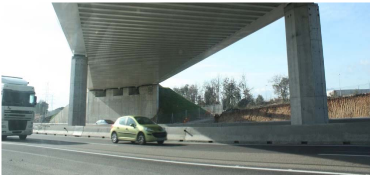
Figura 7. Vista inferior del paso
