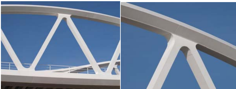
Figura 13. Vista de una de las celosías longitudinales
