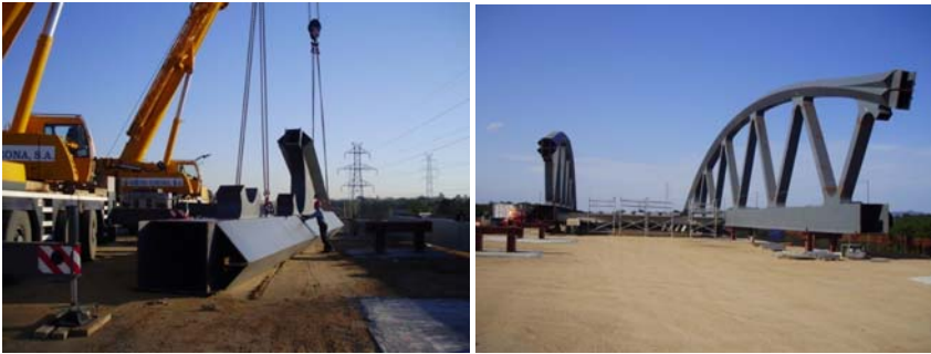
Figura 19. Ensamblaje de las celosías en obra
