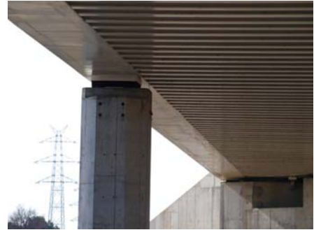
Figura 12. Vista de una de las pilas
