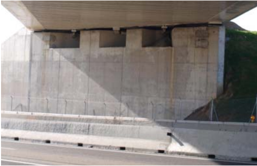
Figura 11. Vista del alzado de un estribo
