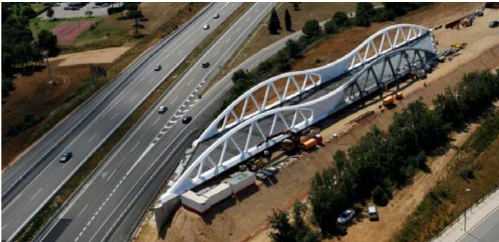
Figura 20. Vista de la estructura preparada para el empuje
