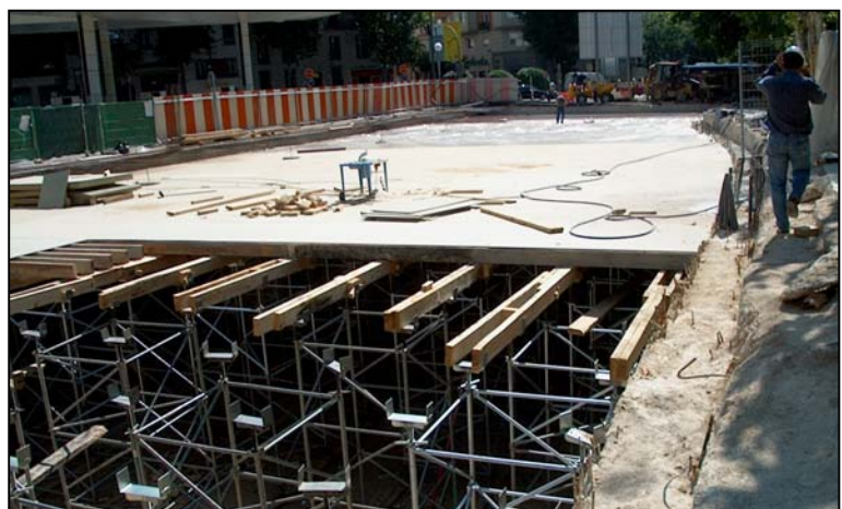
Figura 24. Cimbrado de la losa de la entrada al paso
