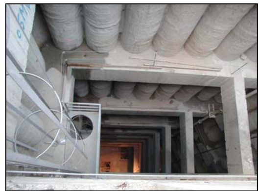
Figura 36. Ejecución, excavación y fase estructural terminada de un pozo, pilotes de 1.00 m de diámetro y marcos de arriostramiento
