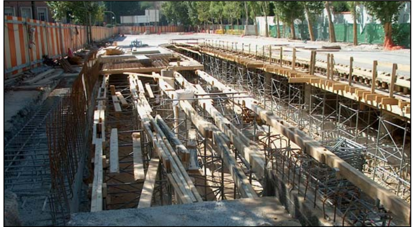
Figura 268. Zona de pilares en la salida a López de Hoyos, en la margen izquierda sentido avance hacia López de Hoyos el carril del túnel avanza hacia López de Hoyos, a la altura de las secciones EP2 y EP3 de la planta de la figura 21.
