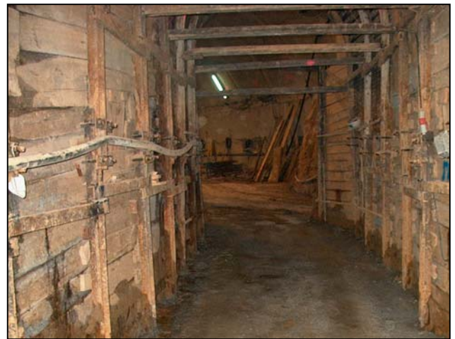
Figura 32. Ejecución del hastial armado que puentea la línea 9 de Metro que va apoyado en pilotes de diámetro 1.25m
