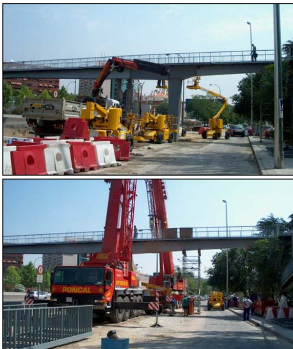
Figura 37. Apeo de la pasarela durante las operaciones de ampliación
