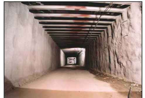
Figura 14. Resultados de pantallas con estampidor intermedio 1HEB-280 cada 2.50m acero S-275
