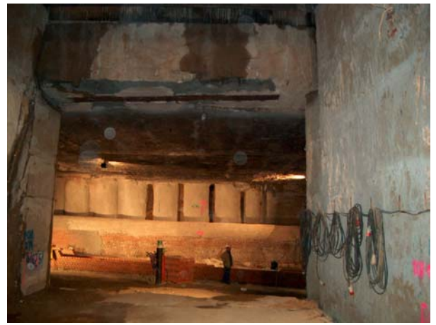
Figura 28. Corte de los pilotes de 1.50 m de diámetro en el "telescopio" de María de Molina Paso del ramal de Velázquez por el primer nivel del "telescopio". En la foto de la izquierda se observan los pilotes de la cara norte de salida cortados, así como el refuerzo de la losa sobre la que transita el tráfico de la calle Velázquez. En la foto de la derecha, se observan los pilotes que faltan por cortar en la cara sur de entrada al Telescopio.
