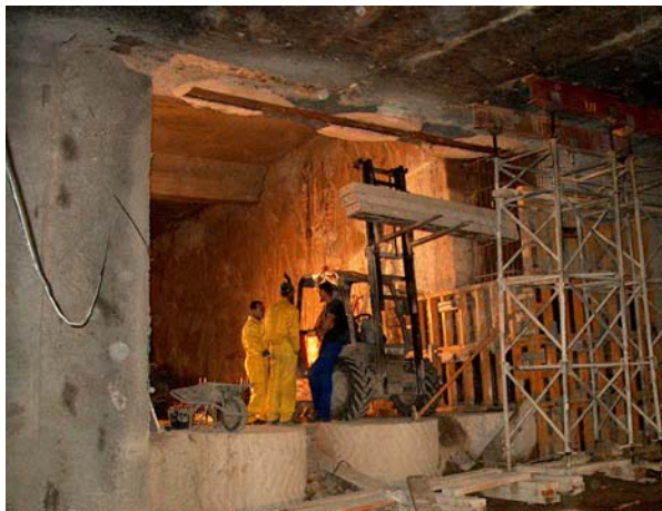
Figura 28. Corte de los pilotes de 1.50 m de diámetro en el "telescopio" de María de Molina Paso del ramal de Velázquez por el primer nivel del "telescopio". En la foto de la izquierda se observan los pilotes de la cara norte de salida cortados, así como el refuerzo de la losa sobre la que transita el tráfico de la calle Velázquez. En la foto de la derecha, se observan los pilotes que faltan por cortar en la cara sur de entrada al Telescopio.
