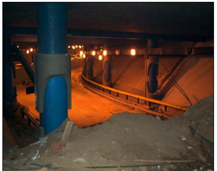
Figura 20. Ramal a López de Hoyos, entrada al túnel por el carril izquierdo y salida a López de Hoyos por el derecho, dejando por detrás los pilares del paso antiguo
