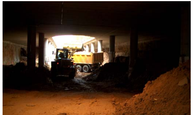
Figura 23. Embocadura de la salida nueva a López de Hoyos a la derecha y a la
