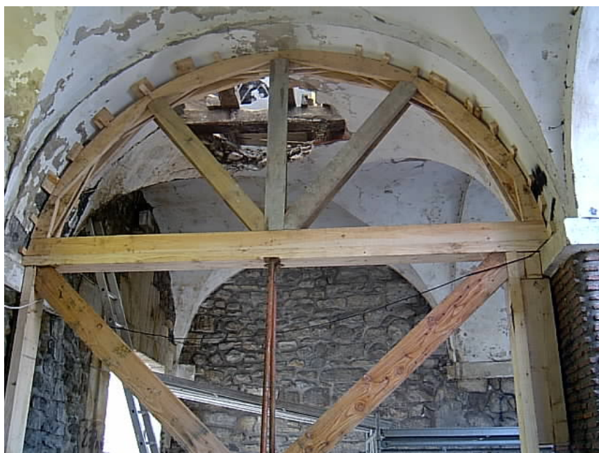
Figura 24. Acondicionamiento de senos de bóvedas y arcos formeros en la zona del claustro.
