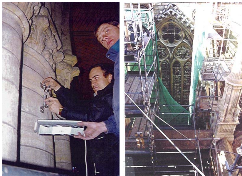
Figura 11. Auscultación en la Catedral de León después de la intervención de 1999 en la Silla de la Reina.
