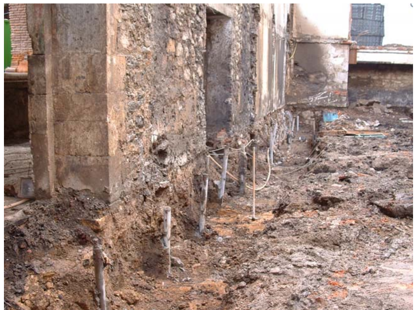
Figura 23. Recalce de la cimentación de los muros mediante un encepado corrido con parejas de pilotes y un muro de hormigón adosado.
