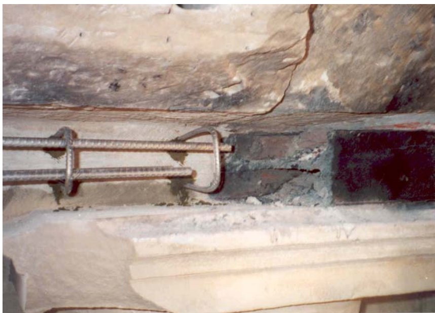
Figura 27. Dintel de hormigón junto a tramo metálico previo a su extirpación.
