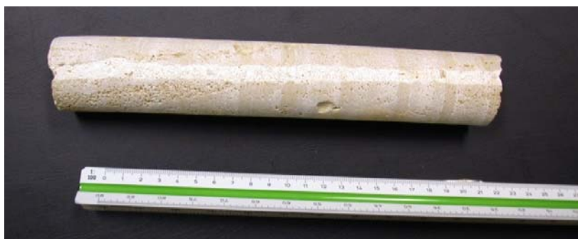
Figura 30. Aspecto de una de las muestras extraídas por la junta (8 mm) entre sillares de pila.
