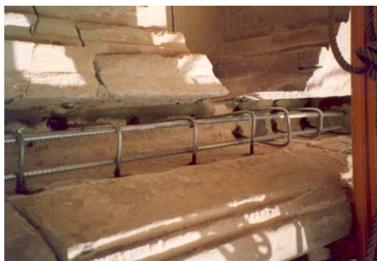
Figura 10. Sustitución de los perfiles metálicos de la figura 9 por uno de hormigón en el que la armadura es sólo de control de fisuración. Trabajo de los autores (2000).
