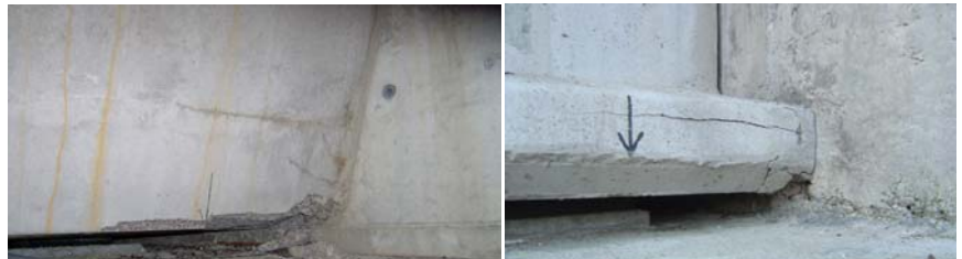
Figura 15. Compresiones no previstas en la cabeza inferior de dinteles.
