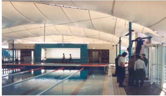
Cubierta Piscina C. Comercial Colombo Lisboa
