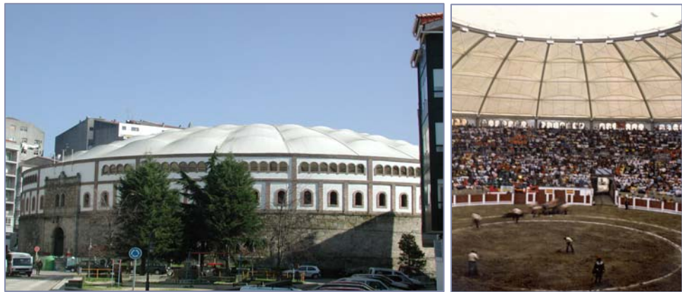
Cubierta de la Plaza de Toros de Pontevedra
