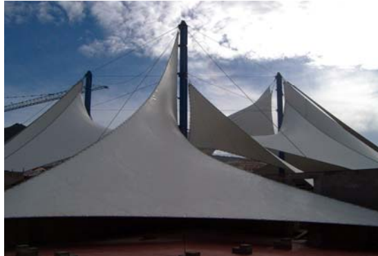
Cubierta Centro Comercial Fañabé Tenerife
