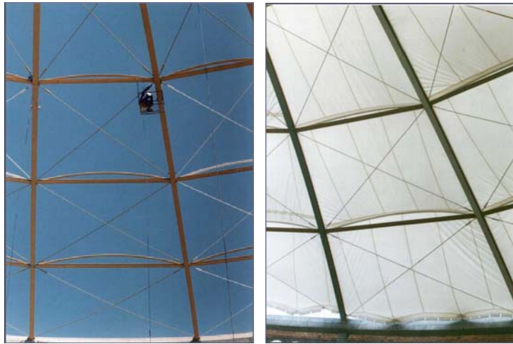
E sbeltez de una solución estructural metálica. Plaza de Toros de Pontevedra
