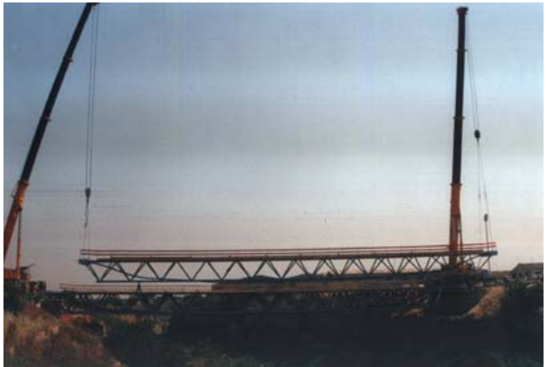
Figura 8 .Colocación de las vigas en obra.
