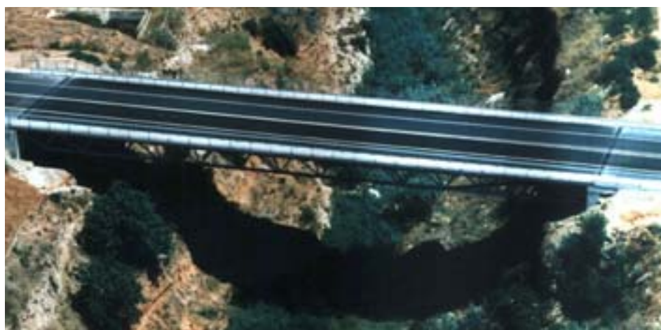
Figura 1. Vista de la estructura terminada.
