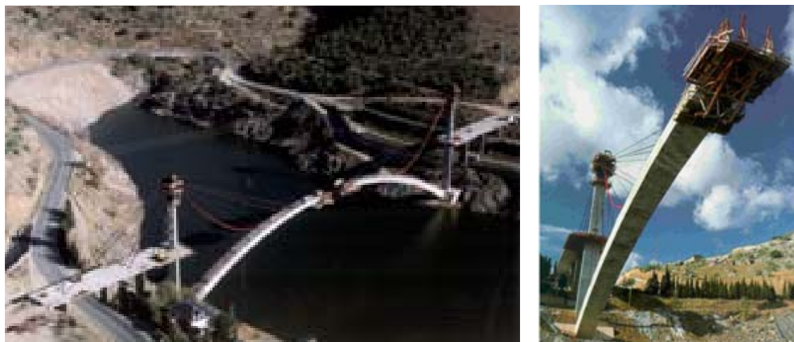
Foto 3. Vistas del arco durante procedimiento constructivo.
