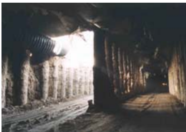
Fotos 4 y 5. Distintas fases de ejecución de los túneles de acceso.
