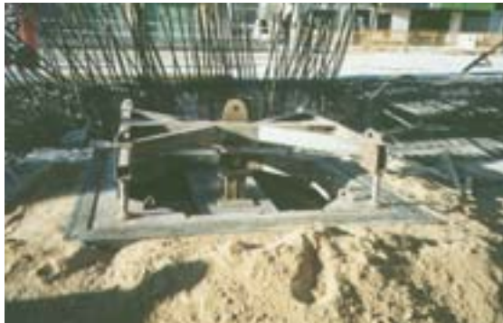
Fotos 2 y 3. Ejecución de pilas-pilote.
