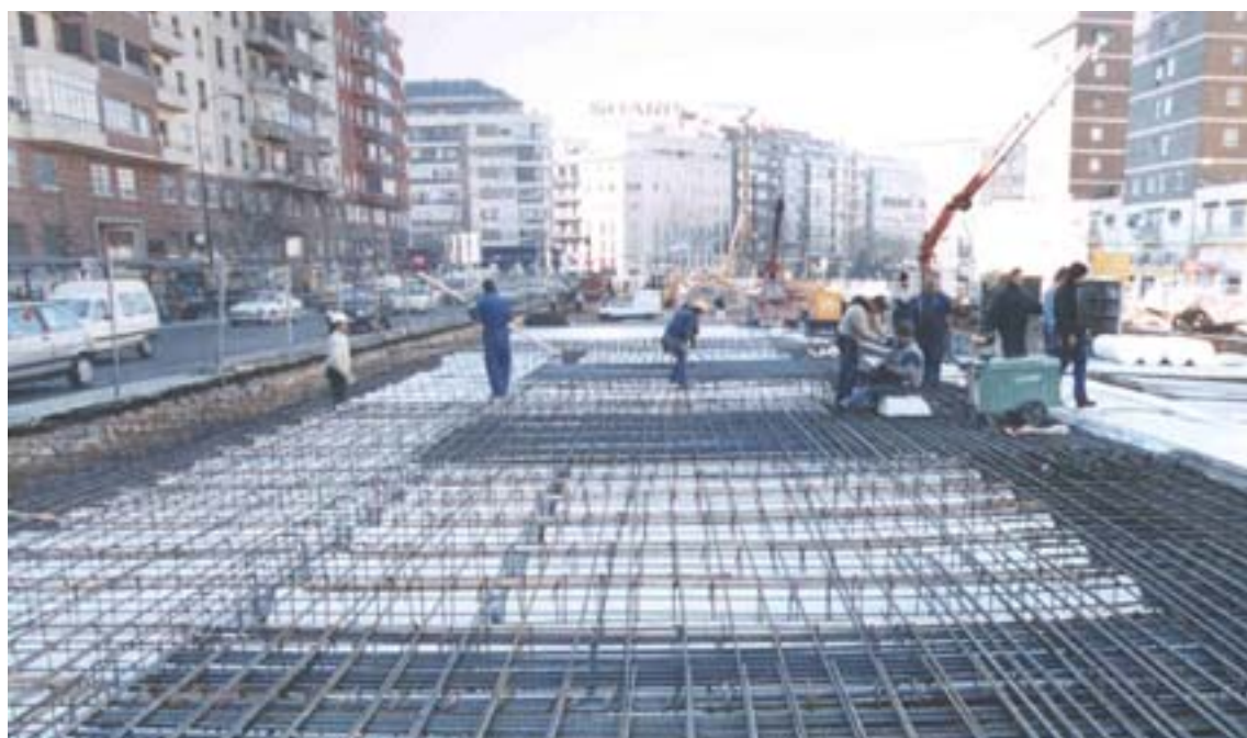
Foto 1. Ejecución de la losa de cubierta.
