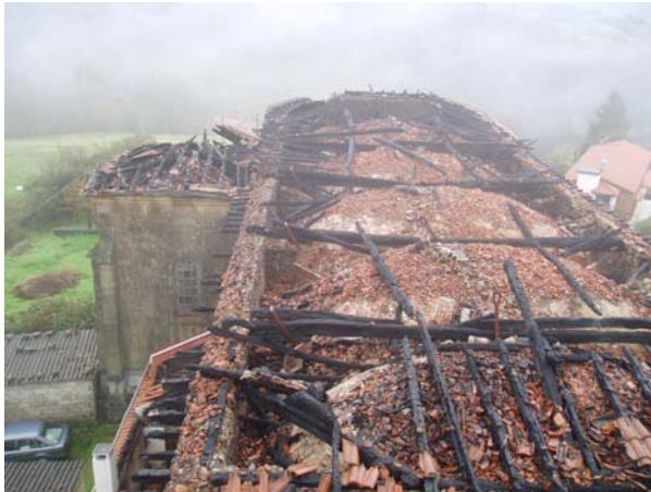
Figura 1 y 2. Vista de la cubierta antes de la retirada de los escombros. Estado del intradós de las bóvedas. Andamiaje y apeo interior.
