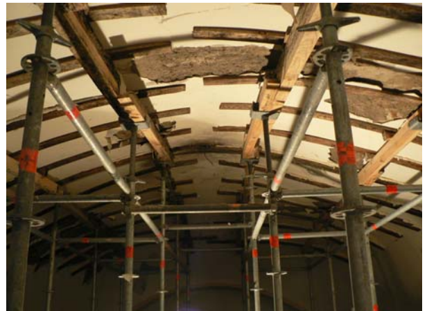
Figura 1 y 2. Vista de la cubierta antes de la retirada de los escombros. Estado del intradós de las bóvedas. Andamiaje y apeo interior.
