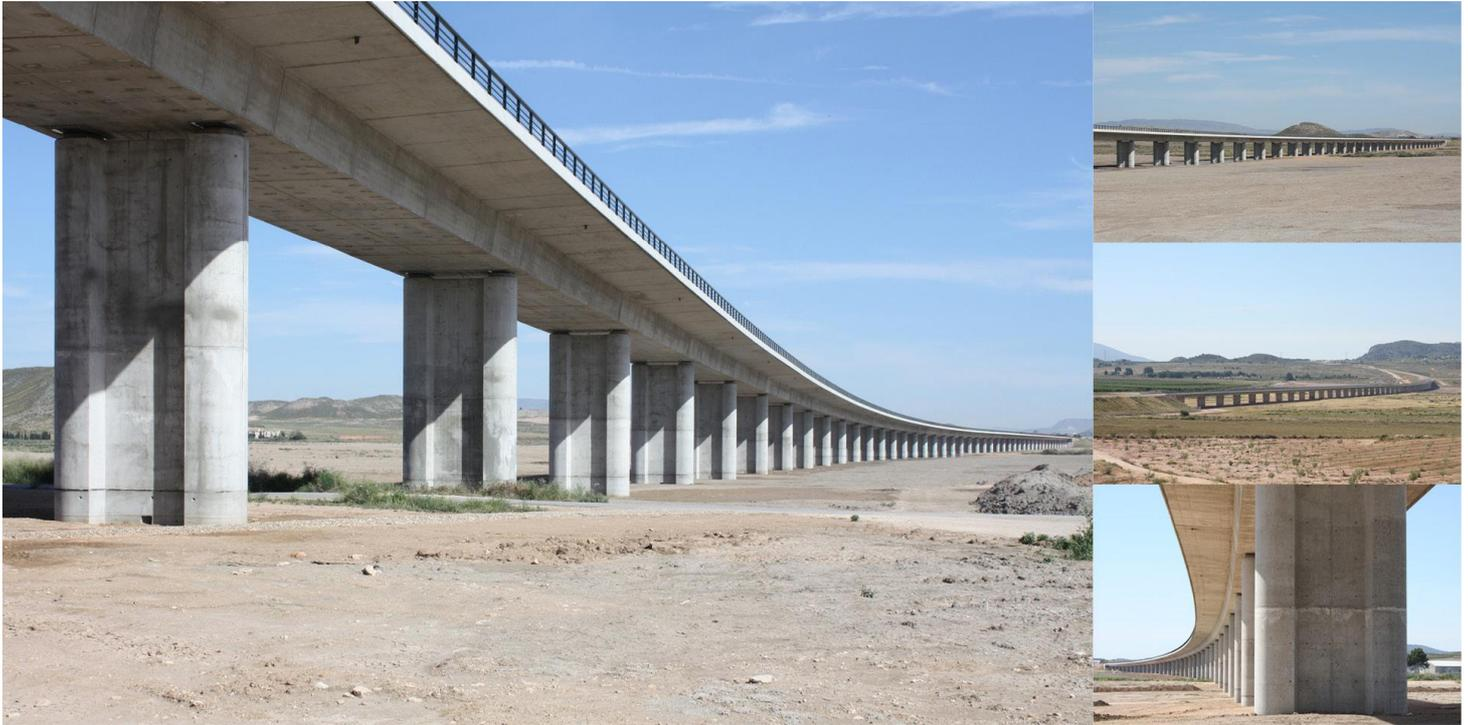
El tramo Villena-Sax de la LAV Madrid-Levante incluye la construcción de dos viaductos de gran longitud: el Viaducto sobre la Acequia del Rey y el Viaducto sobre el Cordel de Sax. El primero de ellos tiene una longitud total de 1394m repartidos en 44 vanos con las siguientes luces: 25+42x32+25m. El Viaducto sobre el Cordel de Sax tiene una longitud total de 1458m repartidos en 46 vanos con las siguientes luces: 25+44x32+25m.
