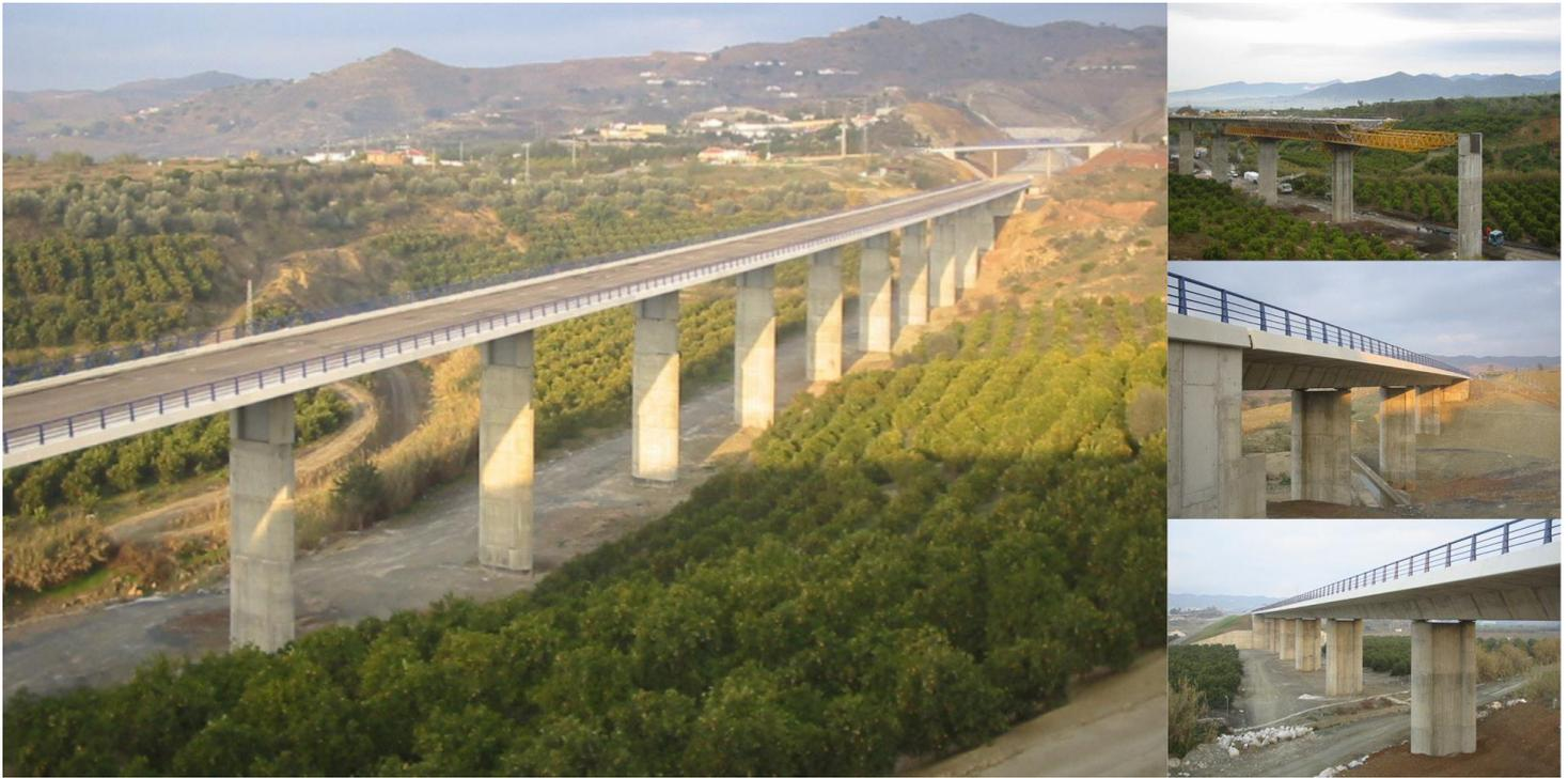
La estructuras proyectadas (Viaductos nº1, 3 y 4) constan de un único tablero (13 vanos en el caso del viaducto nº1, 4 en el viaducto nº3 y 6 en el viaducto nº4), con luces extremas de 25.00 m y luces intermedias de 32.00 m, que dan lugar a longitudes totales de 402.00 m para el caso del viaducto nº1, 114.00 m para el caso del viaducto nº3 y 178.00 m para el caso del viaducto nº4. La anchura del tablero es constante e igual en todos los casos a 14.00 m.
