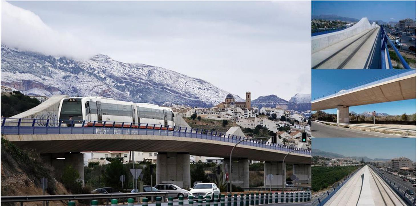
El viaducto ferroviario de Altea se proyectó y construyó con un tablero nervado, que presenta la particularidad de poseer de un "aleta" central que da canto resistente a la estructura por encima de la rasante. Las propiedades que caracterizan la superestructura:
