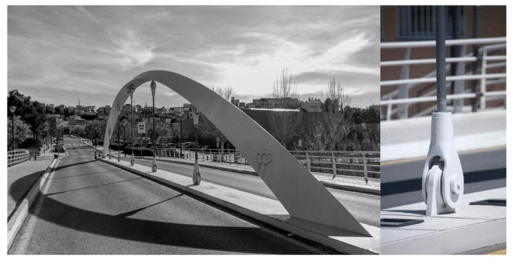
La estructura proyectada cuenta con un único vano de 31 m de luz entre apoyos, y está compuesta por un tablero mixto, un arco metálico, 5 cables cerrados de acero galfanizado y unos estribos-cargaderos de hormigón armado. La anchura total de la estructura se estableció en 14.00 m, de los cuales los 9.00 m centrales se destinan al tráfico rodado, quedando 2.50 m en cada uno de los laterales para el discurrir del tráfico peatonal.
