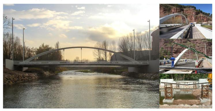
La estructura proyectada cuenta con un único vano de 45,00 m de luz entre apoyos. Está compuesta por un tablero mixto, un arco metálico, 5 cables cerrados de acero galvanizado y unos estribos de hormigón armado. La anchura total de la estructura se estableció en 14,00 m, de los cuales los 9,00 m centrales se destinan al tráfico rodado, quedando 2,50 m en cada uno de los laterales para el uso peatonal.
