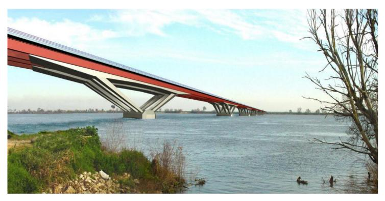
La propuesta presentada para el nuevo puente sobre el río Tajo en Carregado se divide en tres estructuras, el puente principal sobre el río y los viaductos de acceso norte y sur. La longitud total de la estructura es de 11545 m, subdivididos en 1 442.5 m en el Viaducto Norte, 963.5m en el Puente y 9 141m en el Viaducto Sur.
