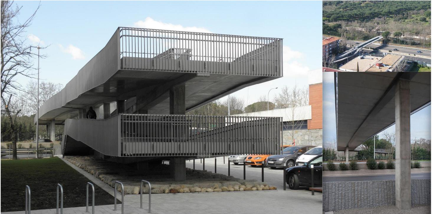
La pasarela denominada "Puente de los Franceses" cruza sobre la M-30 conectando la Plaza de Santa Pola con la casa de Campo. El tramo central está formado por una viga metálica empotrada en cuatro pilares distribuidos dos a dos. La separación de las pilas interiores es de 34,0 metros y la separación entre pilas interiores y exteriores es de 3,0 metros. La viga central tiene una zona en voladizo a partir de las zonas exteriores que se conecta con las rampas de acceso a la pasarela.
