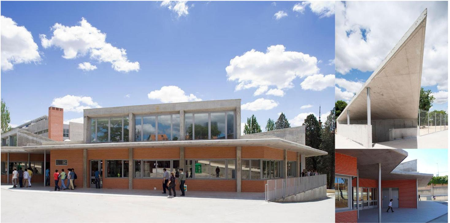
El colegio se ubica en la plaza duque de pastrana. Se trata de una estructura con dos plantas bajo rasante y cuatro sobre rasante, cimentado sobre zapatas. Los forjados son losas macizas armadas con luces máximas de 10m. Se han dispuesto una losa maciza postesada de 0,36 m de canto para salvar un vano con luz de 13 m sin continuidad. En la zona de comedores las cubiertas son losas de hormigón inclinadas.
