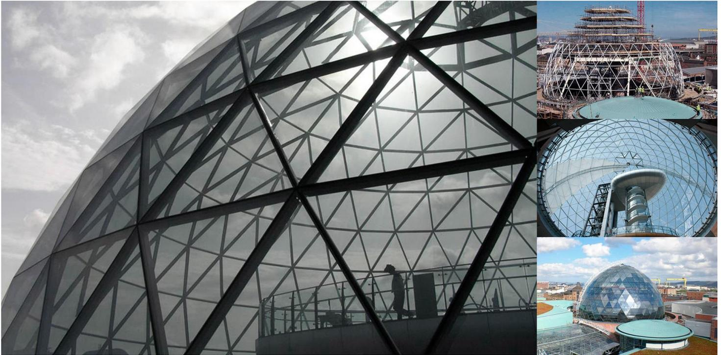
La cúpula del de Victoria Square forma parte de un proyecto de centro comercial que se está desarrollando en Belfast, Irlanda del Norte. Se trata de una cúpula monocapa, concebida por LANIK por encargo de SPACEDECKS LTD, que responde a una estructura laminar formada por una serie de triángulos compuestos por una serie de paralelos y diagonales.
