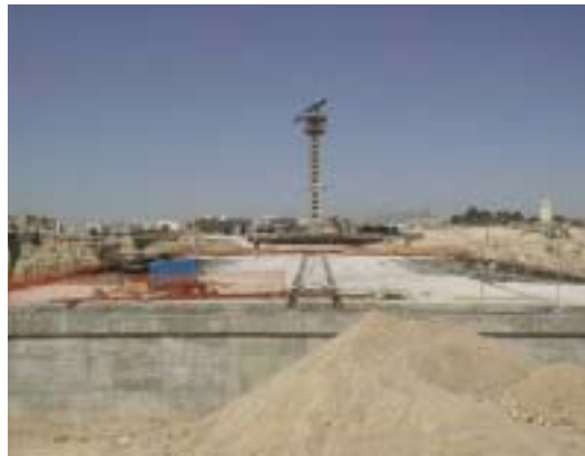
Figura 11. Vistas de la pila desde los contrapesos 1 y 2.
