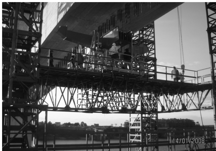
Fig. 11. Colocación de la estructura metálica (Traviesa)
