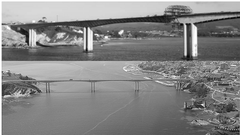
Fig. 1 Vista general del Puente de Los Santos antes del inicio de las obras de ampliación y con las obras avanzadas
