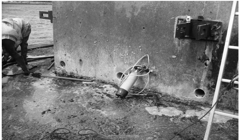
Figura 4. Refuerzo de las cimentaciones de la pilas laterales. Ejecución de taladros.
